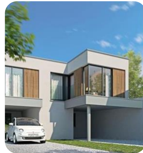
Ruime carport met doorgang
