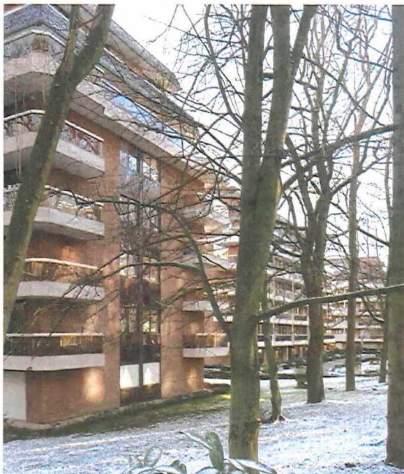
Avenue de Messidor 213, 215 et 217, 2024
