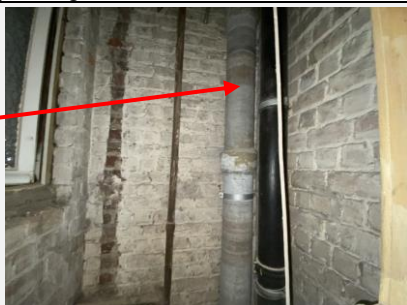
Foto('s) bron: 5, doorvoer (vezelcement)
