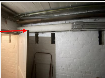
Foto('s) bron: 2, leidingisolatie (gips (isolatie))
