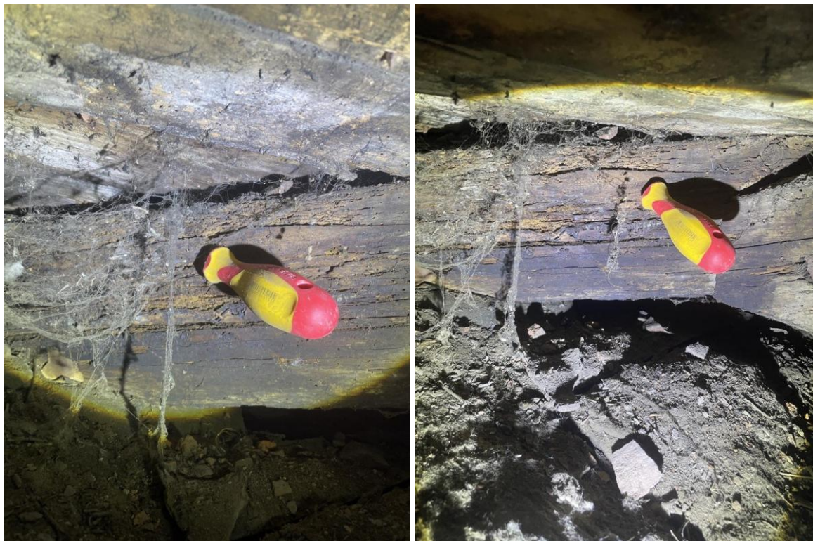
Figure 6 : Photos de l'arbalétrier de noue
