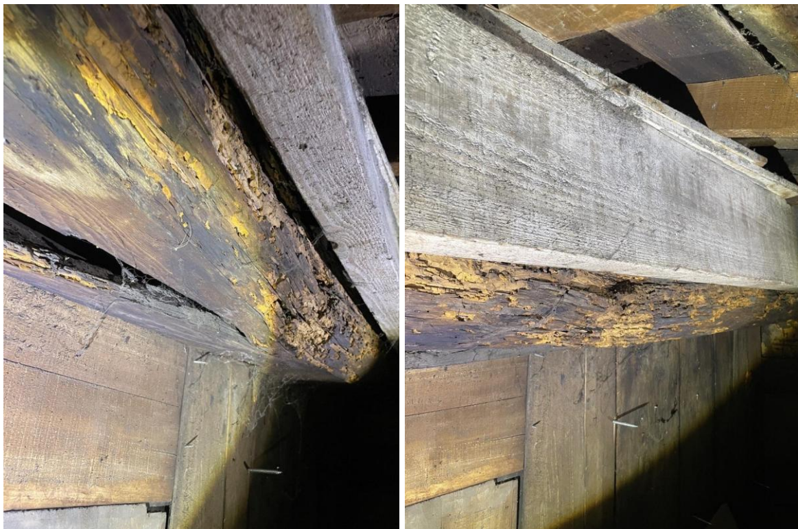
Figure 8 : Photos de la panne faitière
