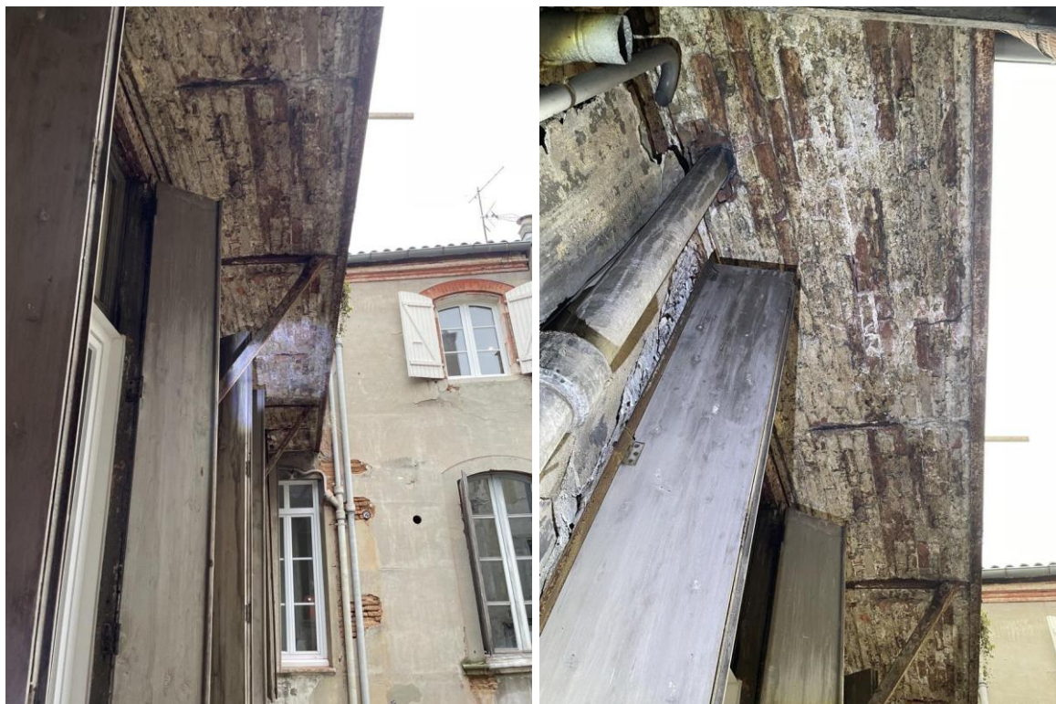
Figure 11 : Vue du dessous du balcon
