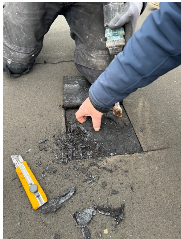
Couches de membrane d'étanchéité (liquide bitumineux)
