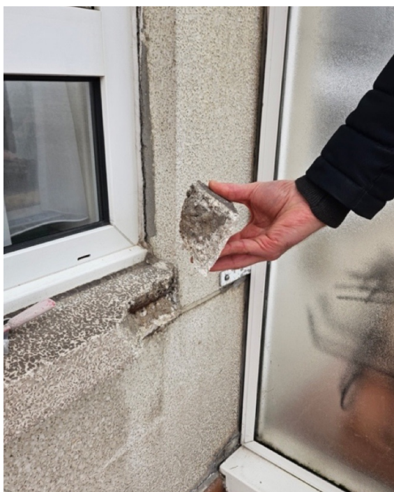
Au n°2, 8 ème étage, en façade avant (Sohy)
