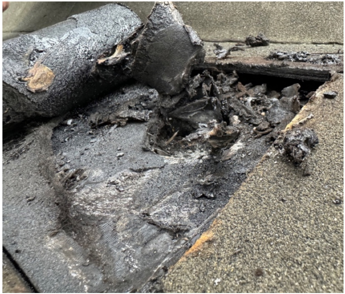
Superposition de couches de membrane d'étanchéité (liquide bitumineux)
