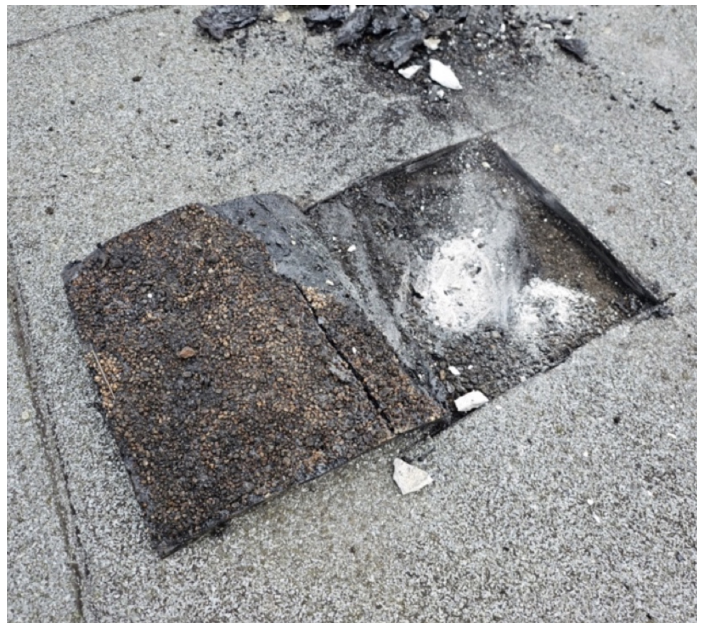
Chape de ciment (sèche)
