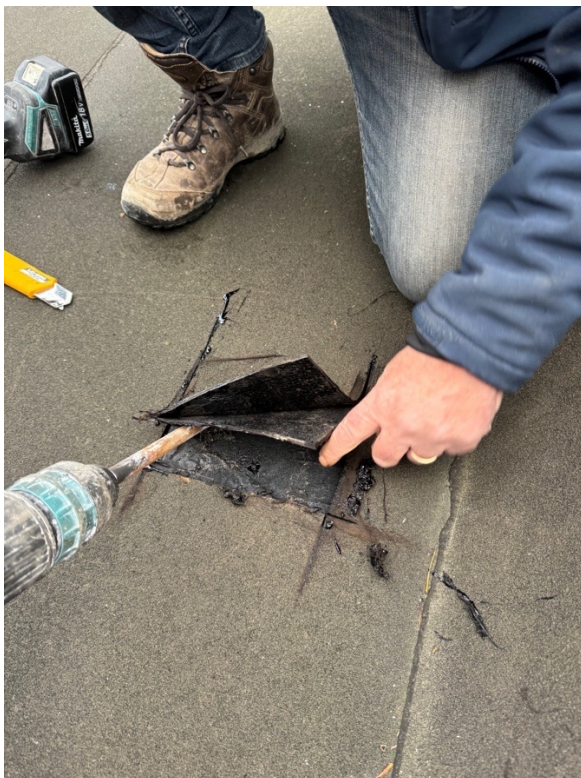
Double couche de membrane bitumineuse sur une partie de la toiture principale
