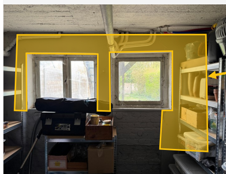
asbestverdachte plaat
