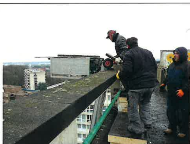
Dépose des dalles sur le plateau élévateur au niveau de la toiture
