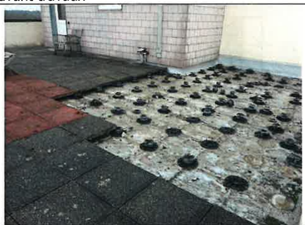
Dépose des dalles sur plots
