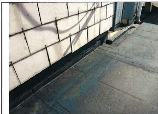
Remontée de l'étanchéité sur les murs
