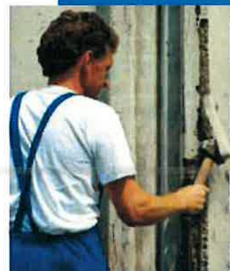
Démolition du béton dégradé
