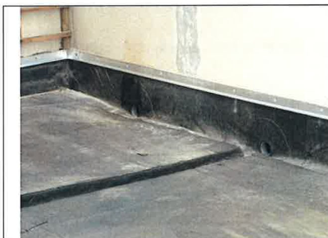
Remontée en plinthe avec solins en aluminium
