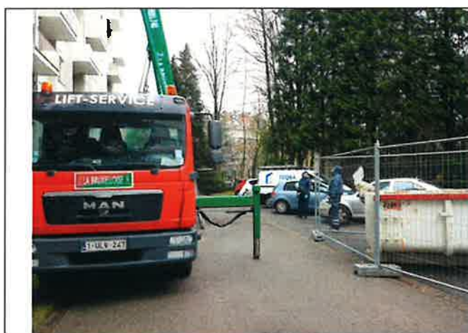
Emplacement du lift sur le parking
