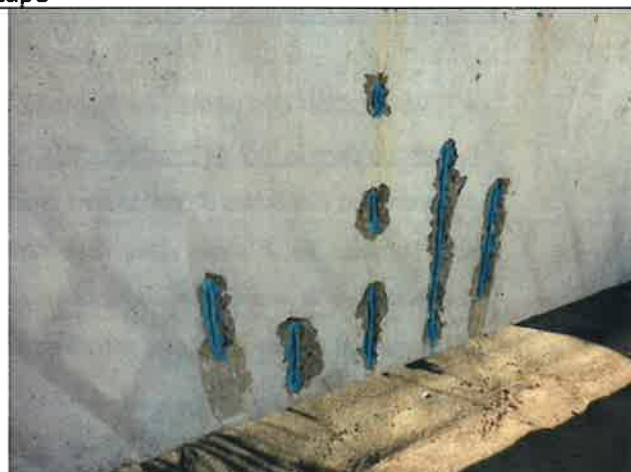
Traitement des armatures
