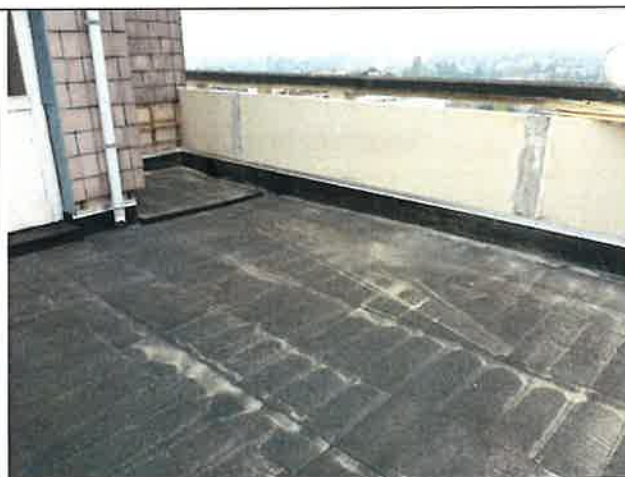
Remontée en plinthe avec solins en aluminium
