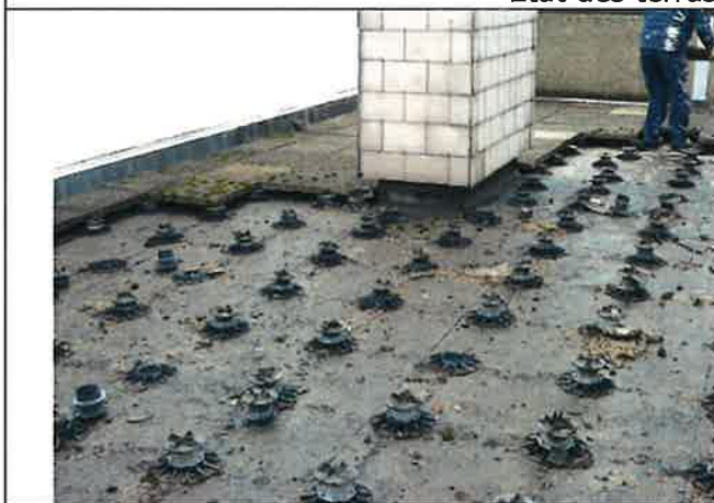
Dépose des dalles sur plots
