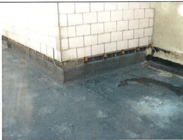
Remontée de l'étanchéité sur les murs
