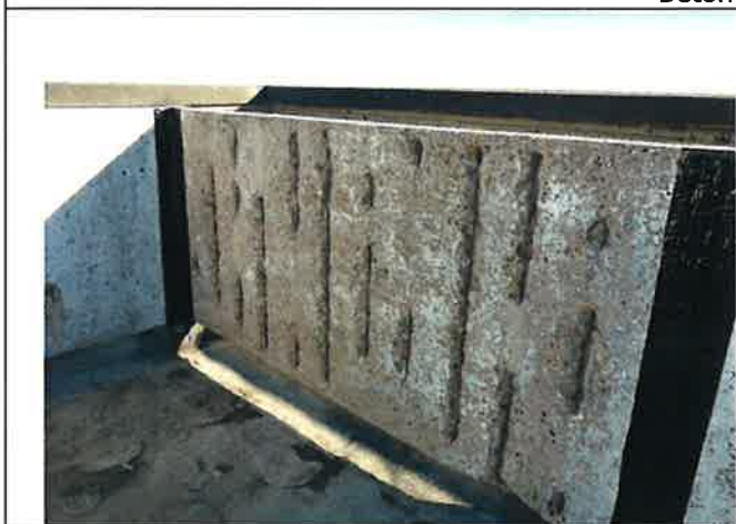
Décapage des armatures
