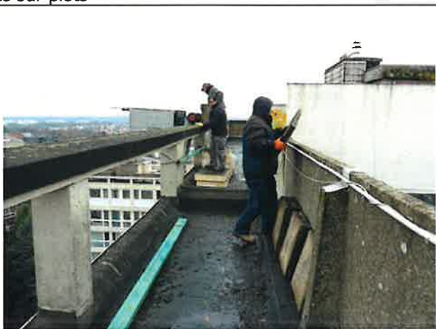
Dépose des dalles sur plots
