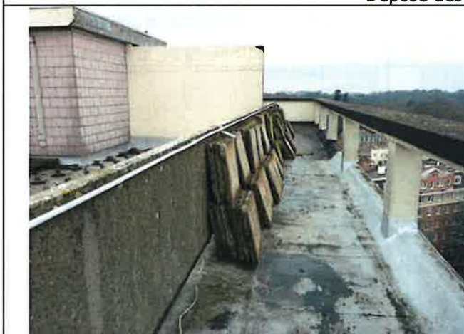
Dépose des dalles sur plots
