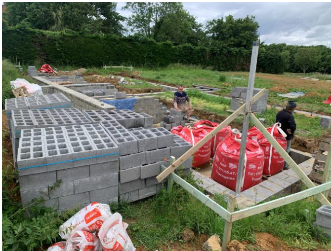
Début des maçonneries
