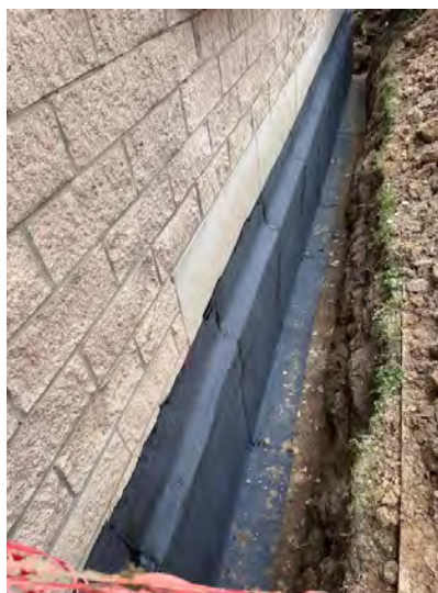
Photo 2 — Membrane d'étanchéité bitumineuse appliquée en continu sur toute la hauteur du soubassement, après dressage du support.
