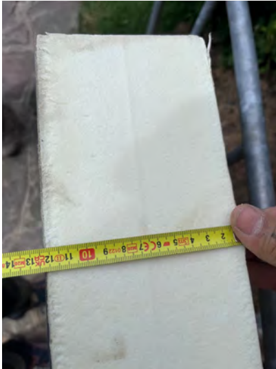
Photo 5 — Contrôle contradictoire de l'épaisseur de l'isolant au mètre ruban : 12 cm.
