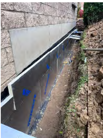
Photo 3 — Pose des panneaux isolants rigides Soprema contre le soubassement étanché, en continu le long de la façade.
