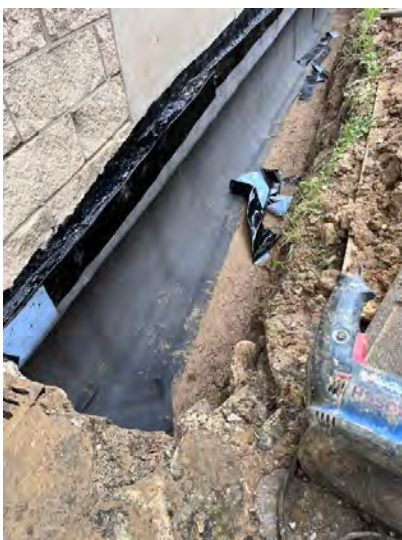
Photo 1 — Fouille ouverte le long de la façade : maçonnerie mise à nu jusqu'en pied de mur et pose de la membrane d'étanchéité en fond de fouille.
