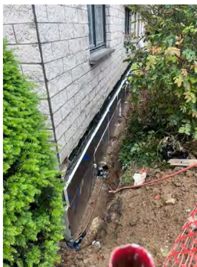
Photo 4 — Autre vue de la même mise en œuvre : panneaux isolants remontant jusqu'au niveau du bandeau, sous les baies du rez-de-chaussée.
