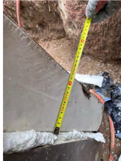
Photo 6 — Second contrôle d'épaisseur, au niveau d'un joint entre panneaux : 12 cm confirmés.
