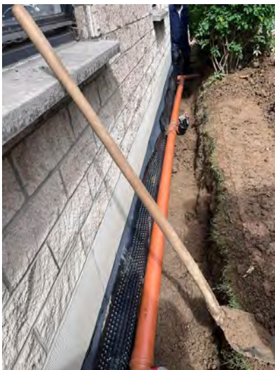
Photo 9 — Collecteur d'évacuation et raccordement — poste « excavation – transport – raccord » du devis n° 2025005.
