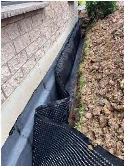
Photo 7 — Membrane de drainage à excroissances déroulée en protection mécanique de l'isolant et de l'étanchéité.
