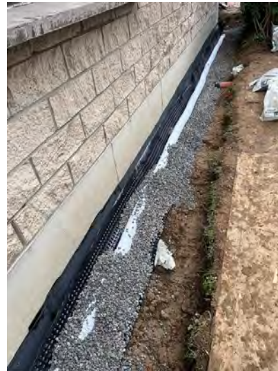
Photo 8 — Drain périphérique en pied de mur et remblai de gravier drainant, sur la membrane à excroissances.
