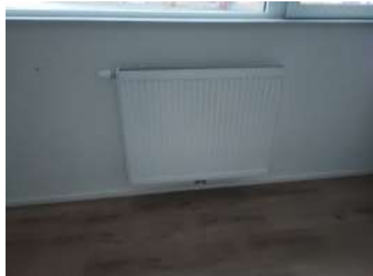
Radiateur à vanne thermostatique
