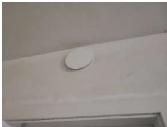
Bouche d'extraction/ventilation
