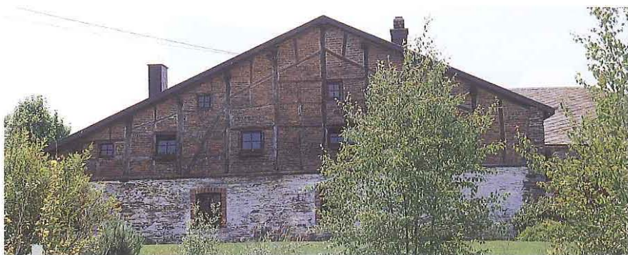
Ample pignon d'une ferme en surface (Goronne)
