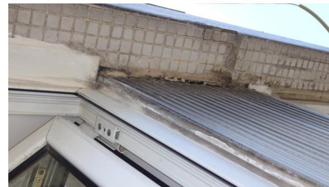
JONCTION CHÂSSIS-PAREMENT
