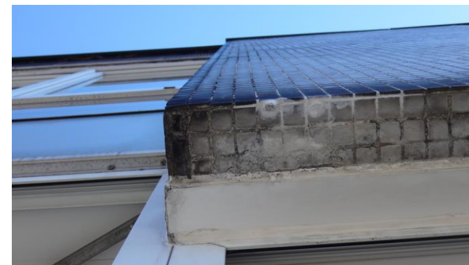
JONCTION CHÂSSIS-PAREMENT
