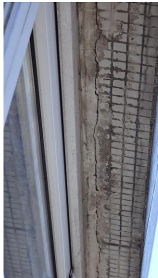
ÉTANCHÉITÉ CHÂSSIS- PAREMENT
