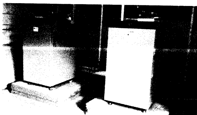
Nouvelles chaudières VIESMANN (chauffage)
