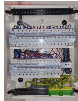
Dispositifs à courant différentiel installés: 2P 40 A 30 mA type A, circuit (s) protégé(s): Voir schémas
