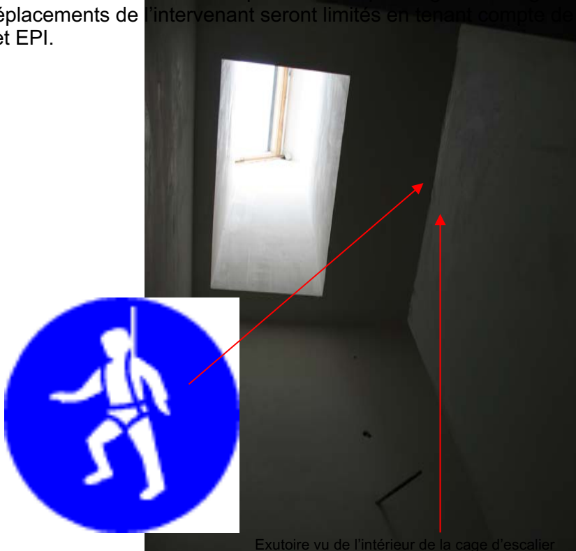
Exutoire vu de l'intérieur de la cage d'escalier
