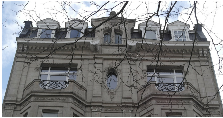
Boulevard du Jubilé 131-133, niveaux supérieurs, 2015
