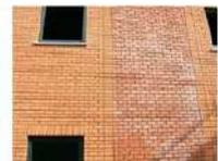
Chantier présentant des efflorescences sur la brique rouge et non sur la brique orange.
