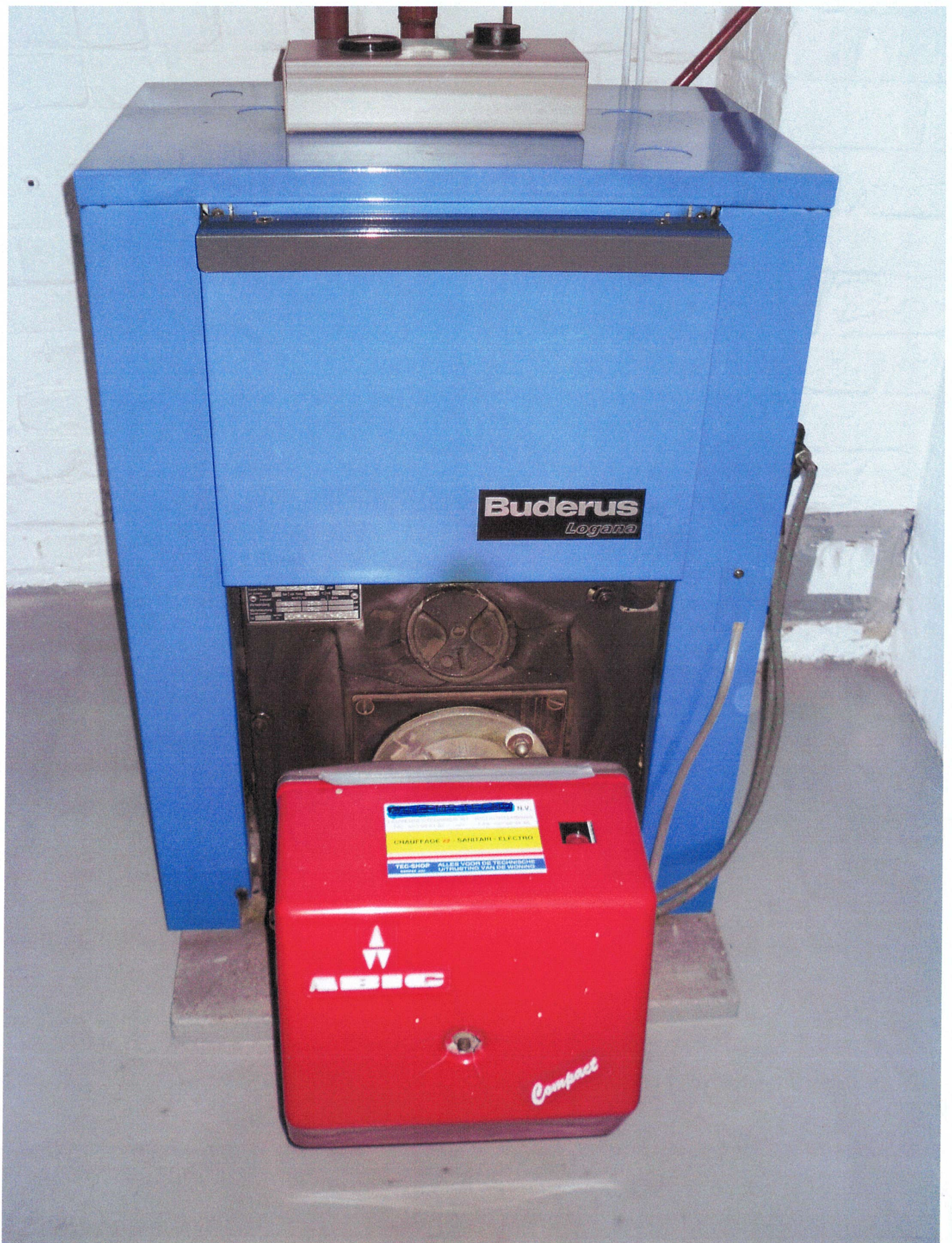
ANCIENNE CHAUDIÈRE MAZOUT
