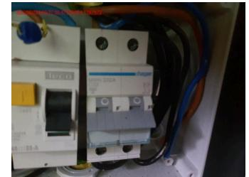
Dispositifs à courant différentiel installés: 4P 40 A 30 mA type A, circuit(s) protégé(s): Voir schémas
