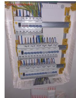
Dispositifs à courant différentiel installés: 2P 63 A 30 mA type A, circuit (s) protégé(s): Voir schémas
