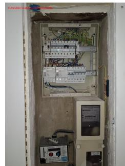
Dispositifs à courant différentiel installés: 4P 40 A 30 mA type A, circuit(s) protégé(s): Voir schémas
