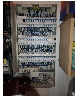
Dispositifs à courant différentiel installés: 4P 40 A 30 mA type A, circuit(s) protégé(s): Voir schémas
